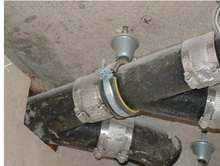
En el caso de la circulación de agua para los equipos de acondicionamiento térmico se utilizaron resortes, fuelles y juntas elásticas.
