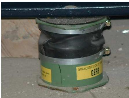
Los equipos de aire acondicionado, equipos de bombeo, grupos generadores y transformadores se montaron sobre atenuadores de vibración específicamente diseñados según el peso, centro de gravedad, y frecuencia de vibración del equipo logrando en todos los casos atenuaciones superiores al 95 %.
