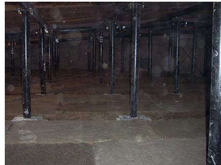
Y el espacio bajo el piso de la platea ambos revestidos con material absorbente (lana de vidrio recubierta con velo de vidrio). De este modo no sólo se atenúa la energía sonora sino que también se reduce la velocidad del aire que sale por los difusores ubicados debajo de la butacas.
