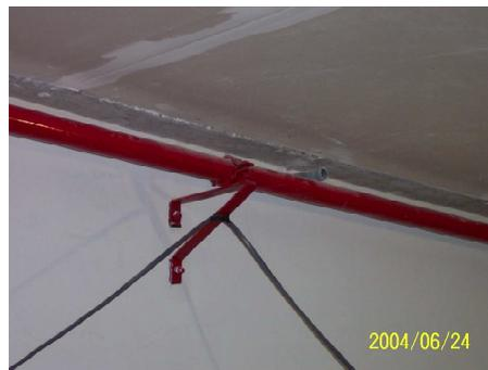
Coherente con lo anterior este tipo de cielorraso no tiene calados o atravesamientos. Como se observa en la imagen las instalaciones se fijan en las paredes.
