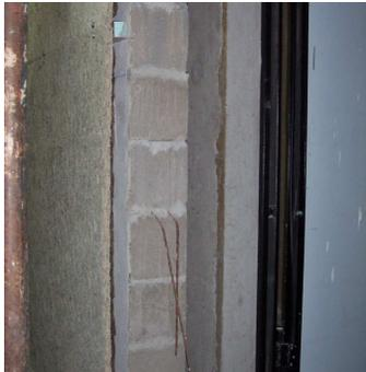
En el diseño de los cerramientos opacos se obtuvieron los grados de aislamiento necesarios por un lado con la incorporación de masa (hormigón estructural por ejemplo en el diseño de las pantallas laterales que conforman la caja escénica o muros de bloque rellenos de hormigón revocados como en el cerramiento de la sala de máquinas de aire acondicionado).
