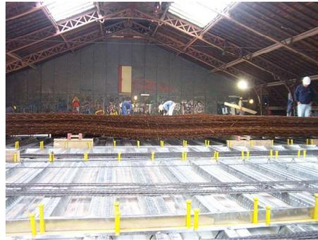
Para aumentar la aislación se levantó el piso de madera de la Sala de Pintura, y en su reemplazo se construyó una losa de hormigón armado de 21 cm. de espesor; apoyada sobre grandes vigas de metal que se apoyan a su vez sobre las paredes portantes del Teatro.
