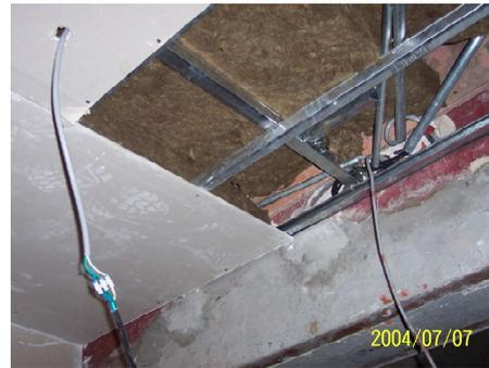
Este sistema constructivo fue empleado también en la ejecución de cielorrasos aislantes en locales emisores de ruido. En la imagen se aprecia la estructura de tirantes de madera y planchuelas existente además de la estructura del futuro cielorraso
