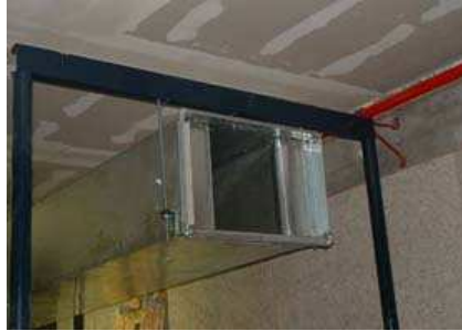
FOTOS 20 - 21: ATENUADOR PASIVO VINCULADO A ESTRUCTURA DE FIJACIÓN
