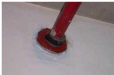
FOTO 17: PASE ACÚSTICO Y CORTAFUEGO
