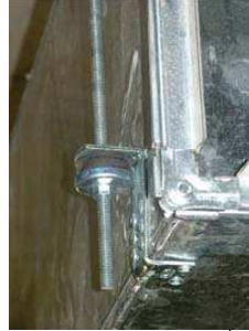
FOTOS 20 - 21: ATENUADOR PASIVO VINCULADO A ESTRUCTURA DE FIJACIÓN
