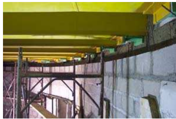
FOTO 4: REMATE DE PARED DE BLOQUE
