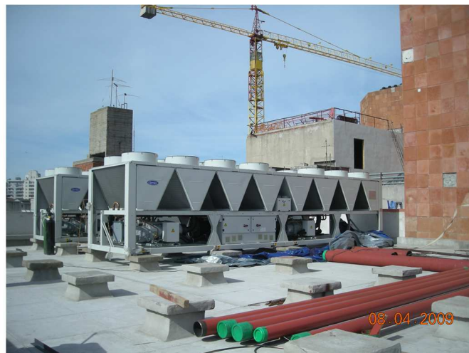
REVESTIMIENTO ABSORBENTE: PANEL PERFORADO – MONTAJE DE CHILLERS AUDITORIO SODRE
