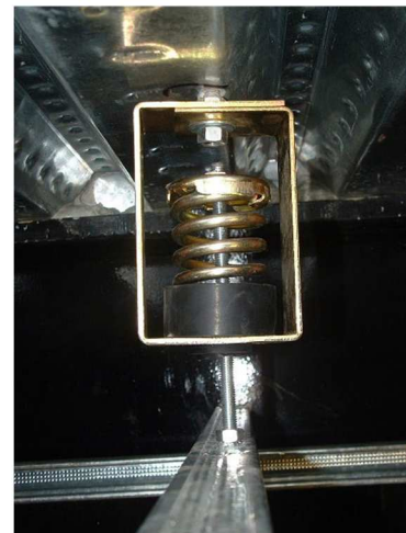
MONTAJE DE RESORTES EN CIELORRASO TEATRO SOLÍS
