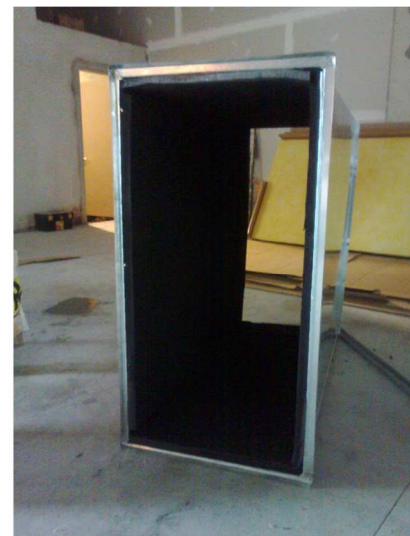
CIELORRASO DE ESTUDIO – REVESTIMIENTO INTERIOR DE DUCTO DE ACOND TÉRMICO POLO TECNOLÓGICO EDUCATIVO UTU EN PREDIO DEL LATU
