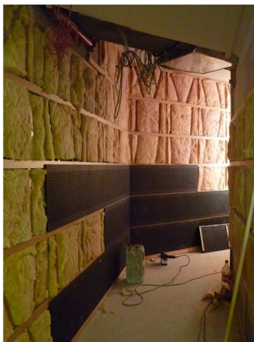
REVESTIMIENTO ABSORBENTE: PANEL PERFORADO – MONTAJE DE CHILLERS AUDITORIO SODRE
