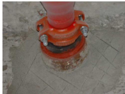
MONTAJE DE INSTALACIONES – SELLADO DE PASES TEATRO SOLÍS
